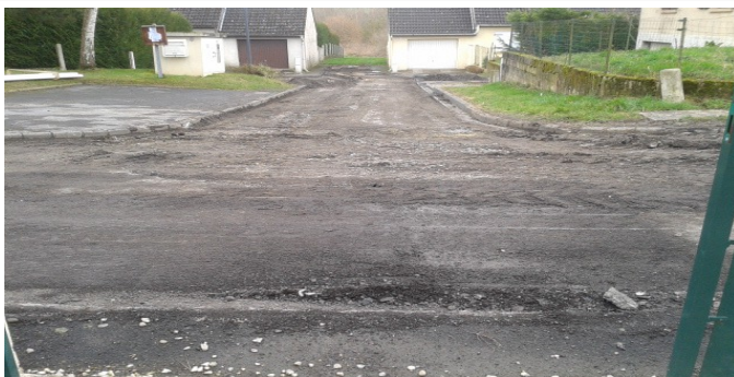
lotissement la Cabourerye en travaux
