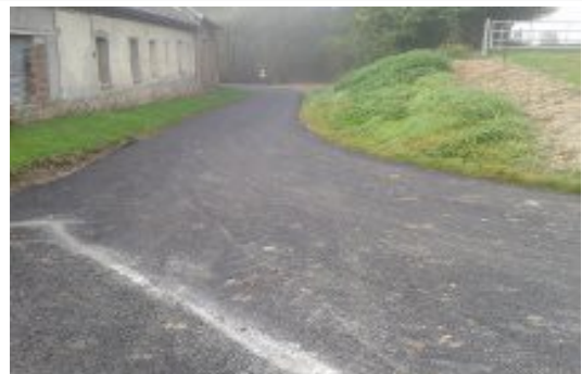
Chaussée rue du moulin de Montescourt
